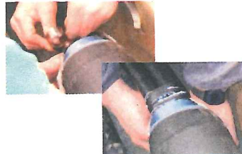
ジャンパー線の接続・処理 (ケーブル遮蔽の接続)
