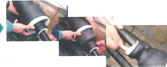
3M 防水処理部材(両端部)の装着
