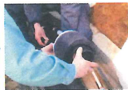
収縮部材の挿入
