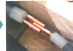
接続子の接続 (ボルト止め)
